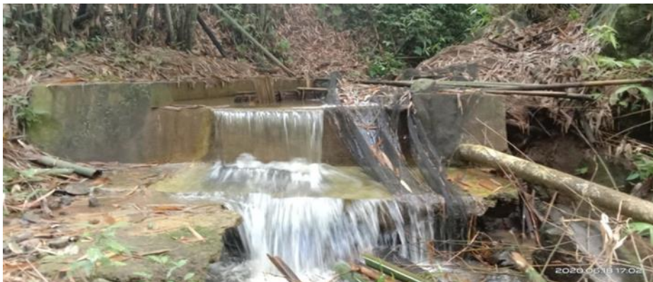
a. Pengolahan air bersih di lokasi penelitian
